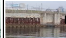
鋼矢板の腐食・ コンクリートの劣化
