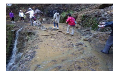
(利用が多い荒廃歩道の再整備)
