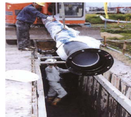
老朽管の更新工事
