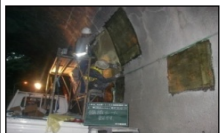
トンネルの修繕
