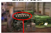
排水機場のポンプ 設備の更新
