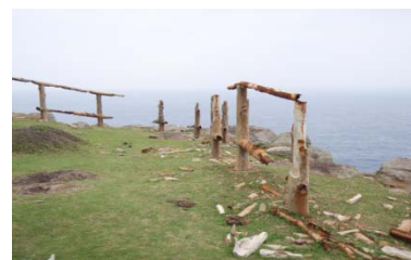
(老朽化した落下防止柵の再整備)
