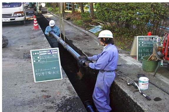
管路の布設工事
